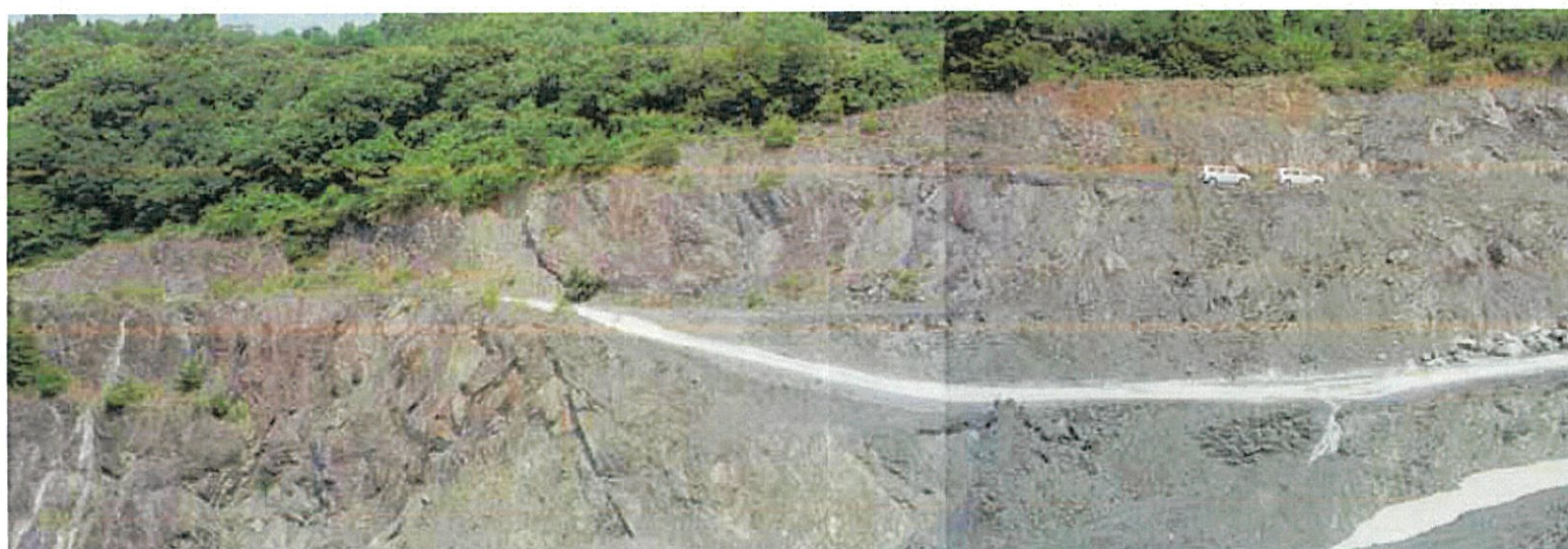
東側のり面全景②(終点方向)
