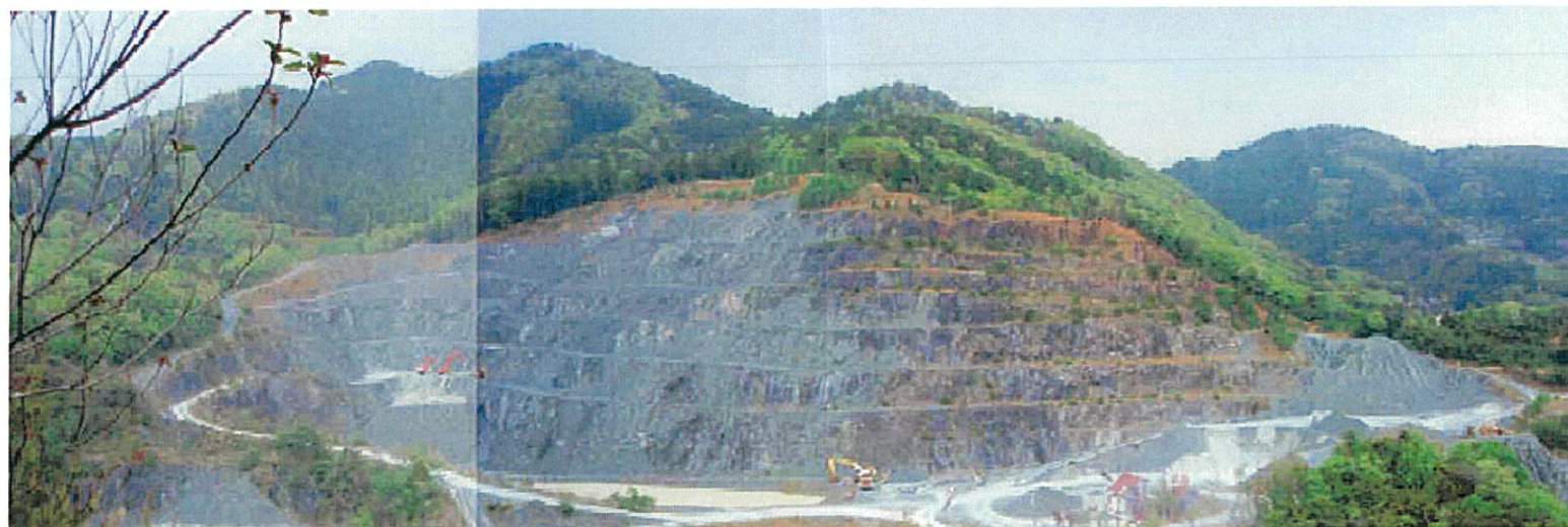
東側のり面全景①(起点方向)
