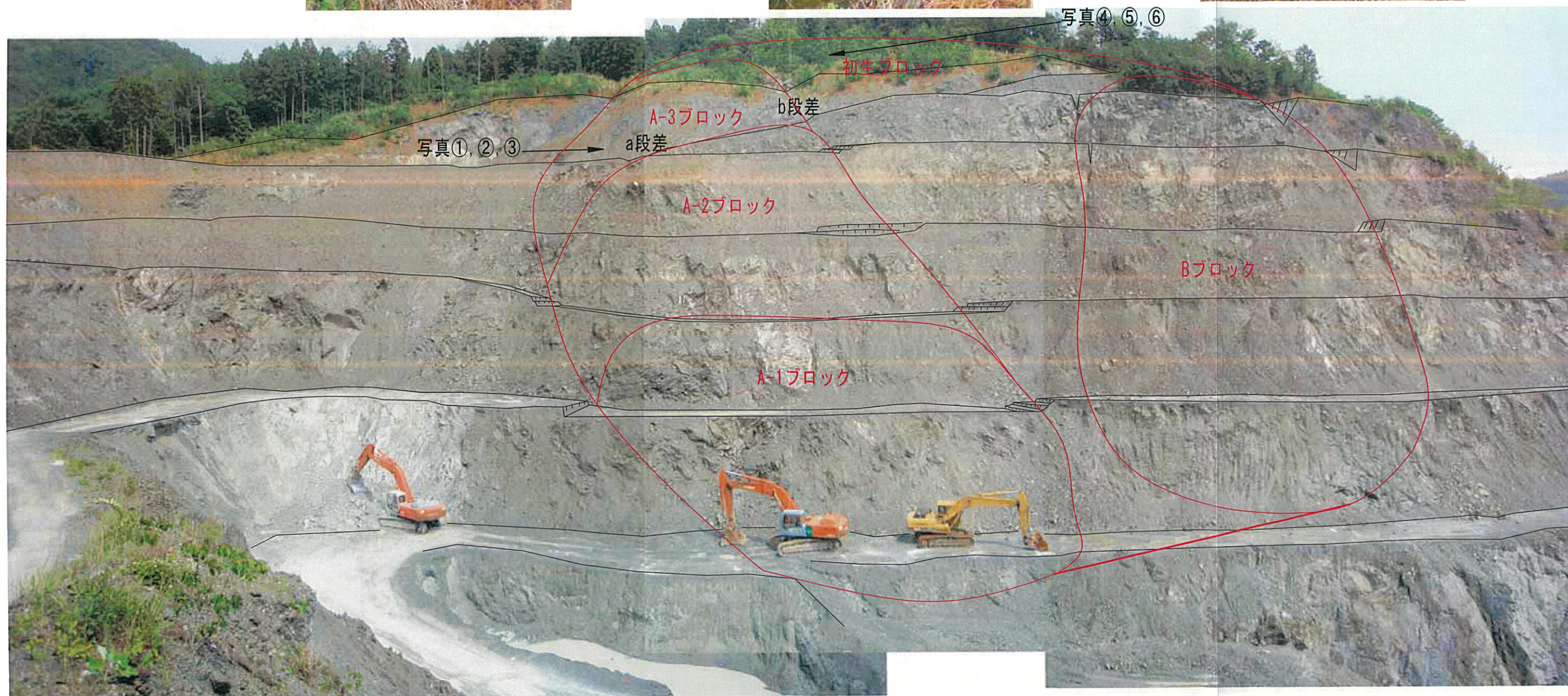
写真③：6月初旬 2次すべり頭部付近 a段差は70cm程度 b段差は小段ごと落ちる
